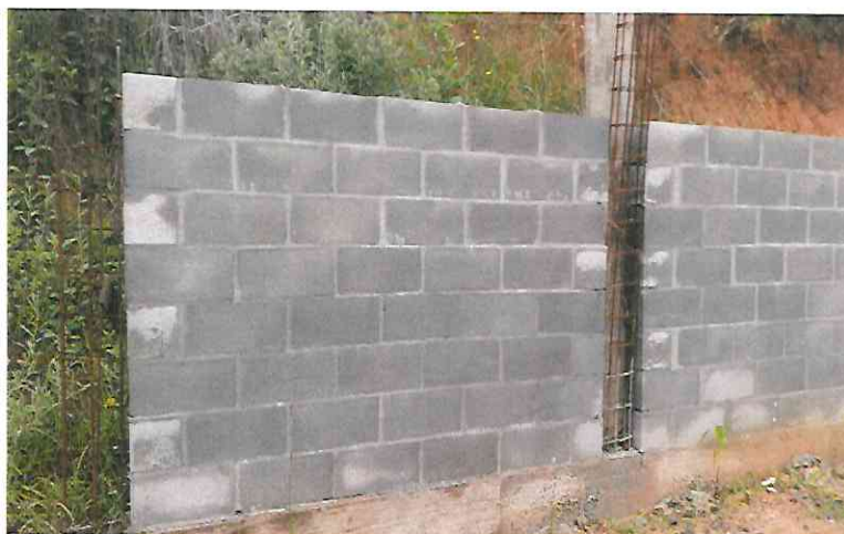
Foto 3 – Muro executado e pilares com armaduras/esperas
