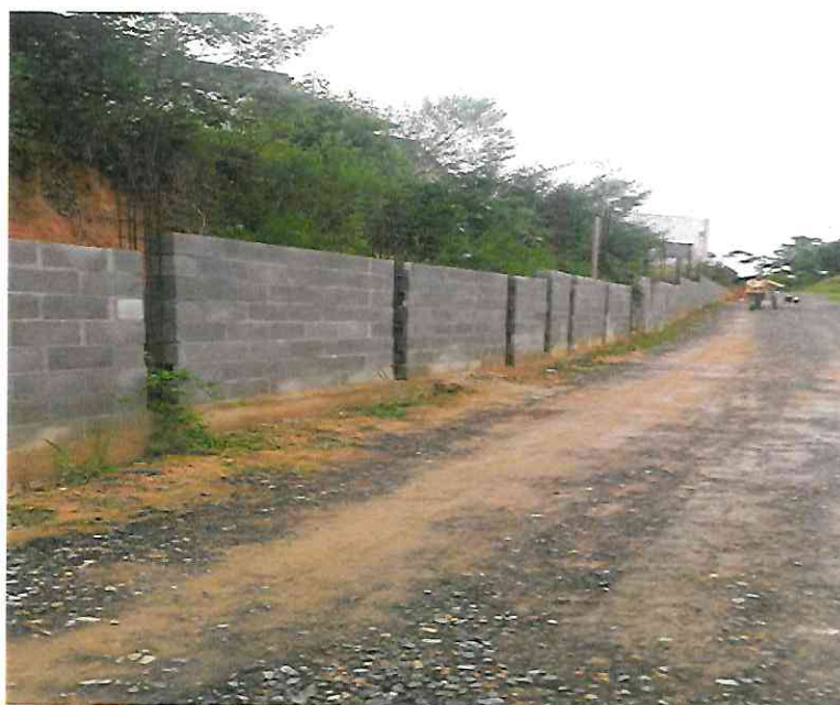
Foto 2 – Muro executado – blocos
