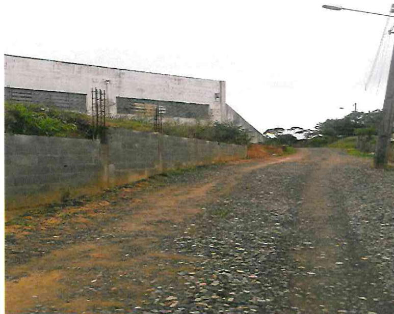
Foto 5 – Muro executado e pilares com armaduras/esperas
