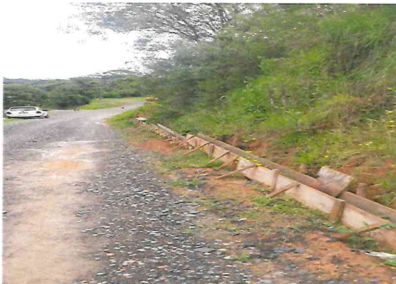
Foto 1 – viga baldrame muro – caixaria executada
