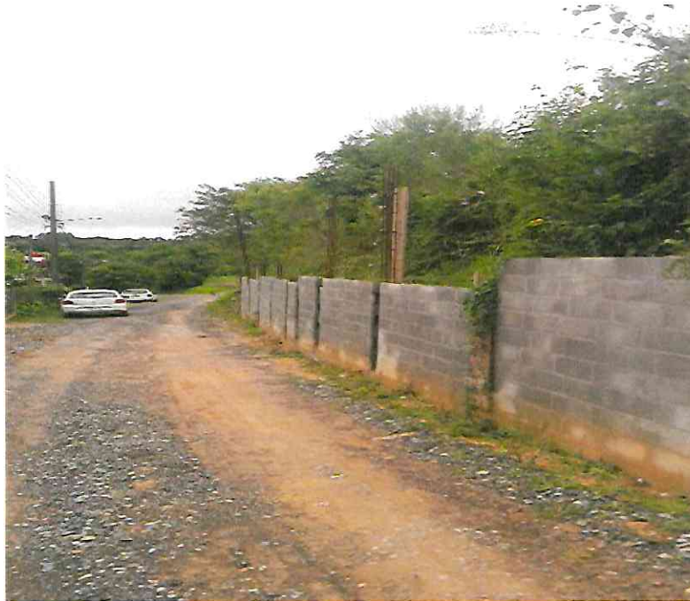
Foto 4 – Muro executado e pilares com armaduras/pilares
