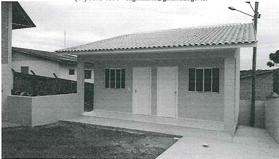
Foto 05: Vista frontal lavanderia
