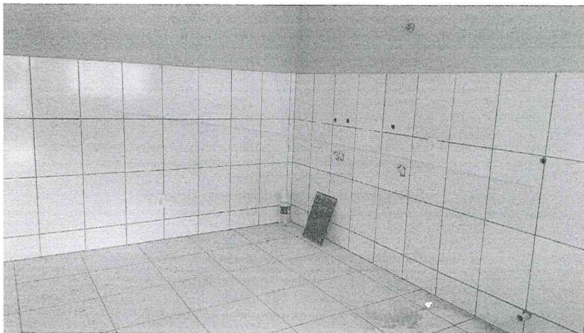
Foto 06: Área interna lavanderia
