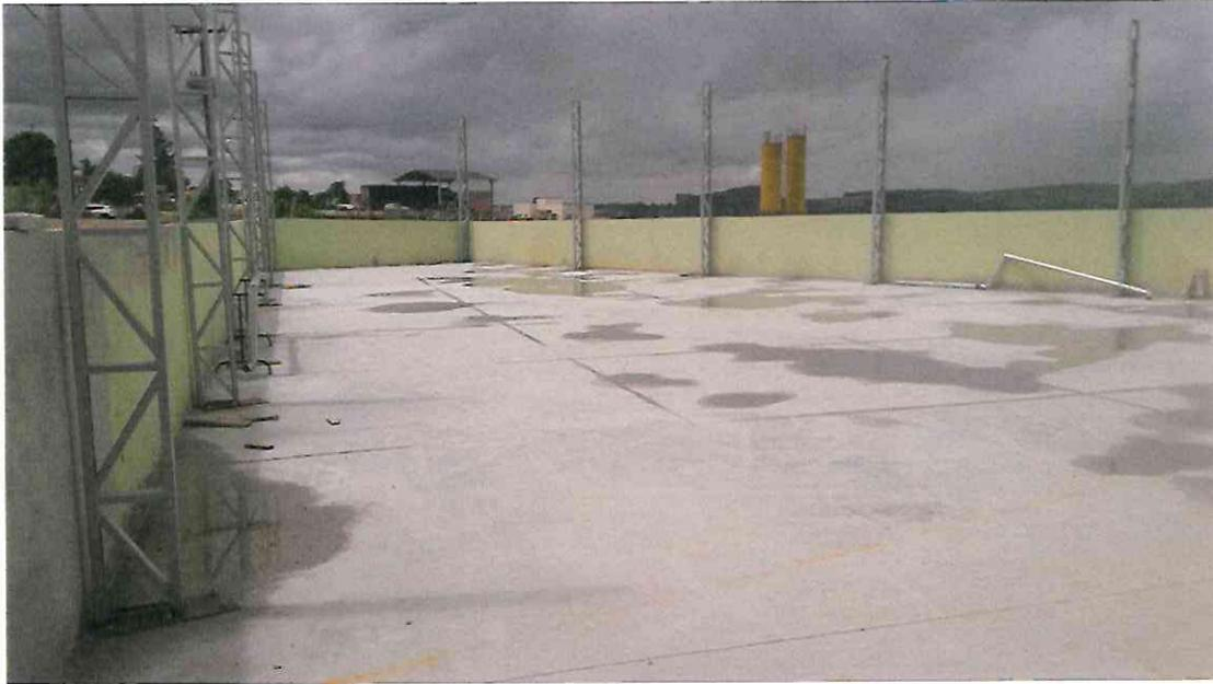
1- Quadra – Serviços medidos: malha de aço CA-60, Piso de concreto, Pilares metálicos
