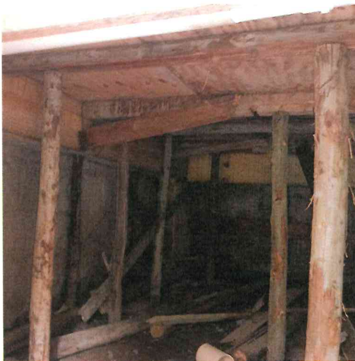
Foto 1 – EXECUÇÃO DE LAJE DE PISO
