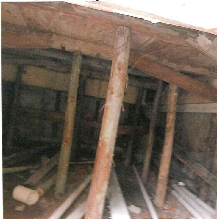
Foto 1 – EXECUÇÃO DE LAJE DE PISO
