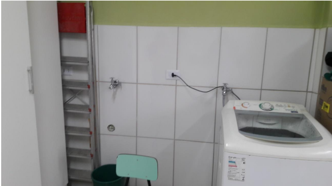
Foto 1 – interno da lavanderia concluído
