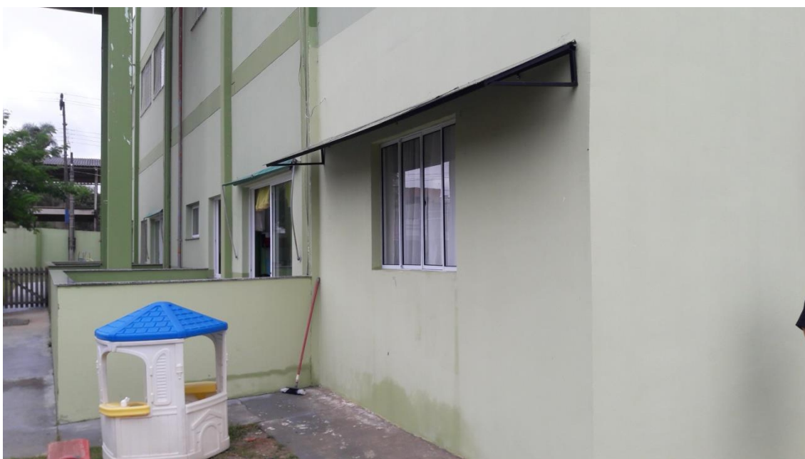
Foto 4 – ampliação da lavanderia concluída
