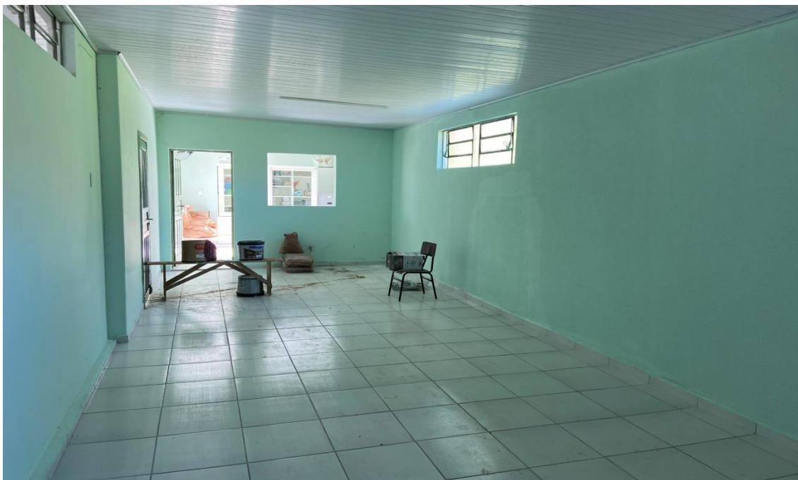
Foto 3 – reforma e adequações do ambiente concluídas
