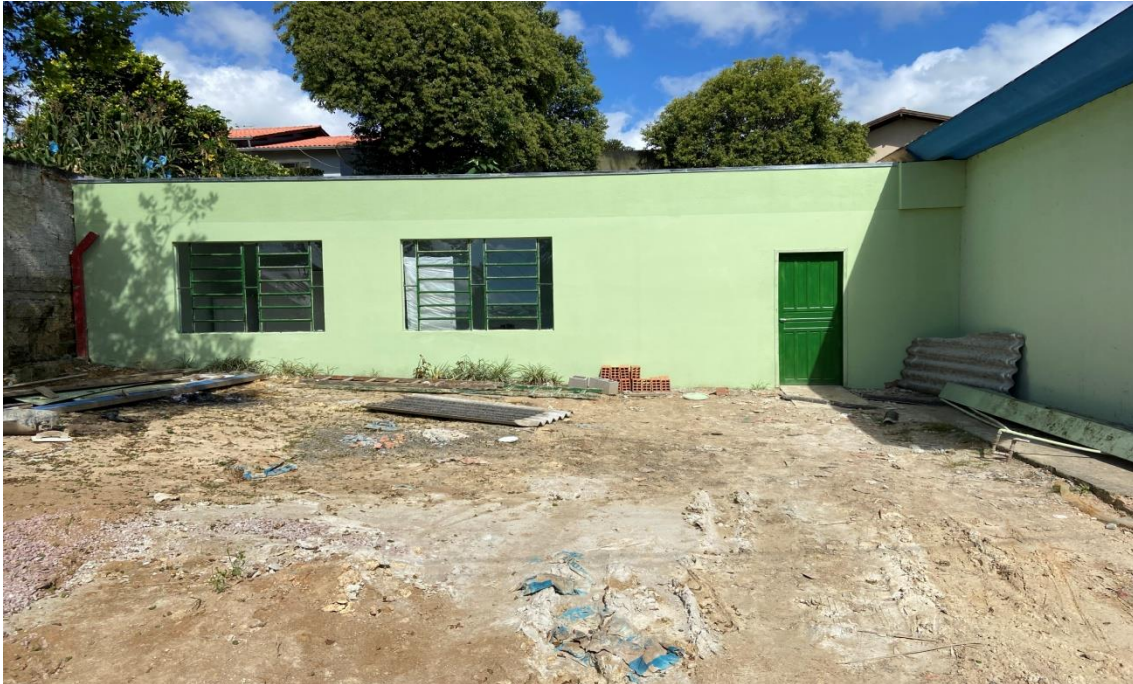
Foto 1 – reforma e adequações do ambiente concluídas
