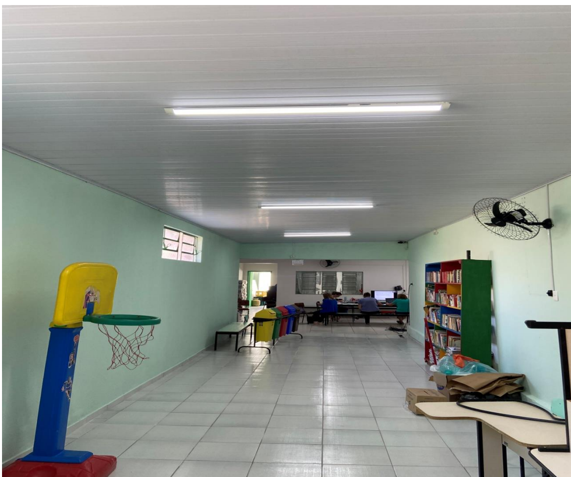
Foto 4 – reforma e adequações do ambiente concluídas
