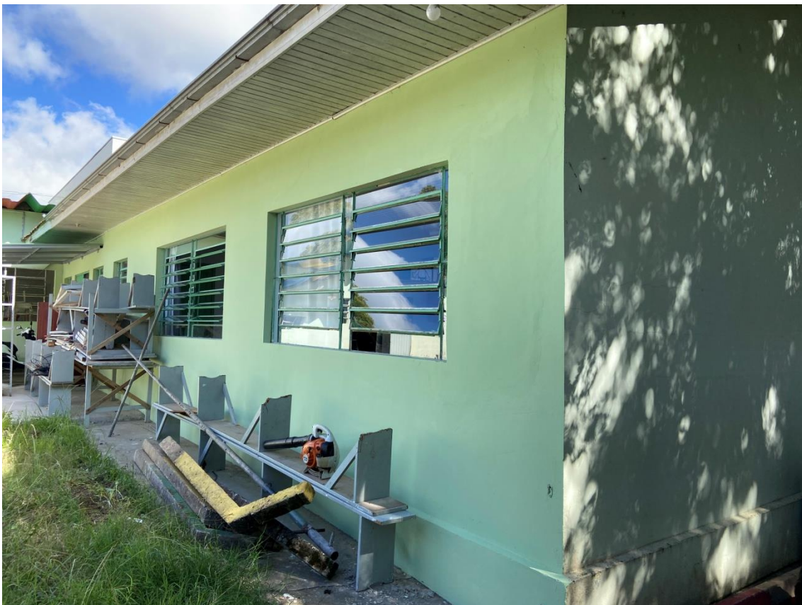
Foto 2 – reforma e adequações do ambiente concluídas
