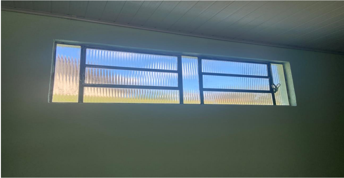
Foto 5 – reforma e adequações do ambiente concluídas
