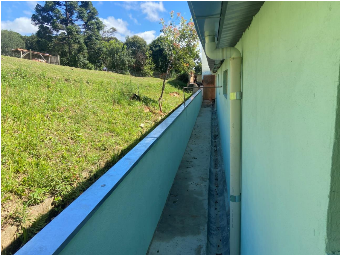
Foto 6 – reforma e adequações do ambiente concluídas
