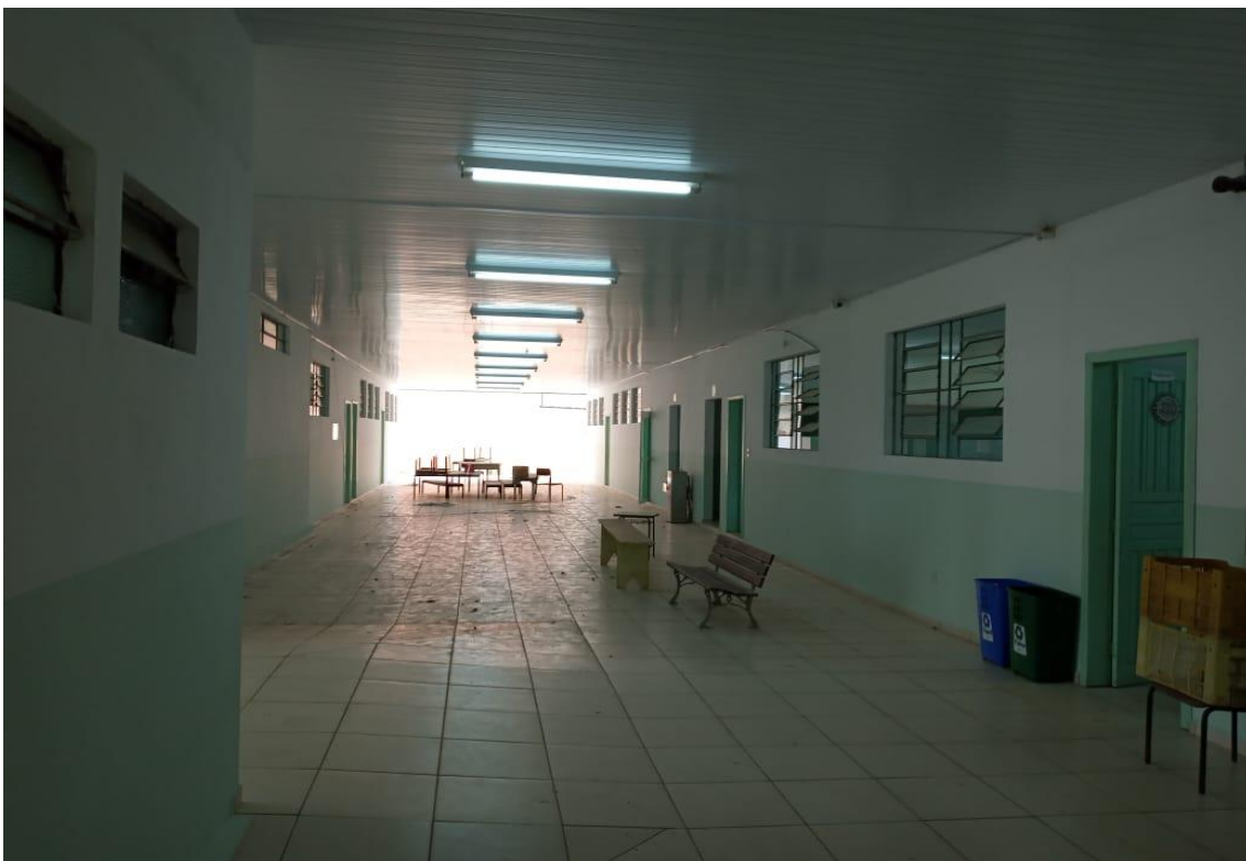
Foto 6 – Pintura interna e correções concluídos
