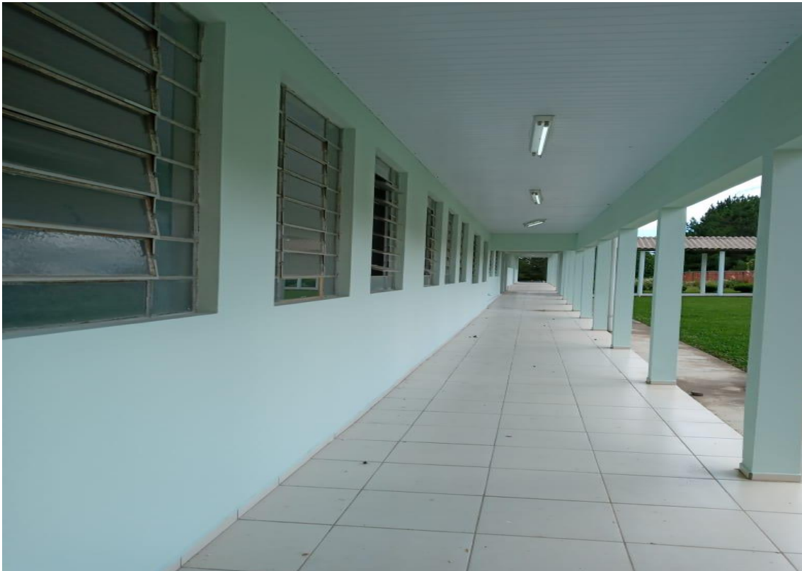
Foto 1 – Pintura externa e correções concluídos
