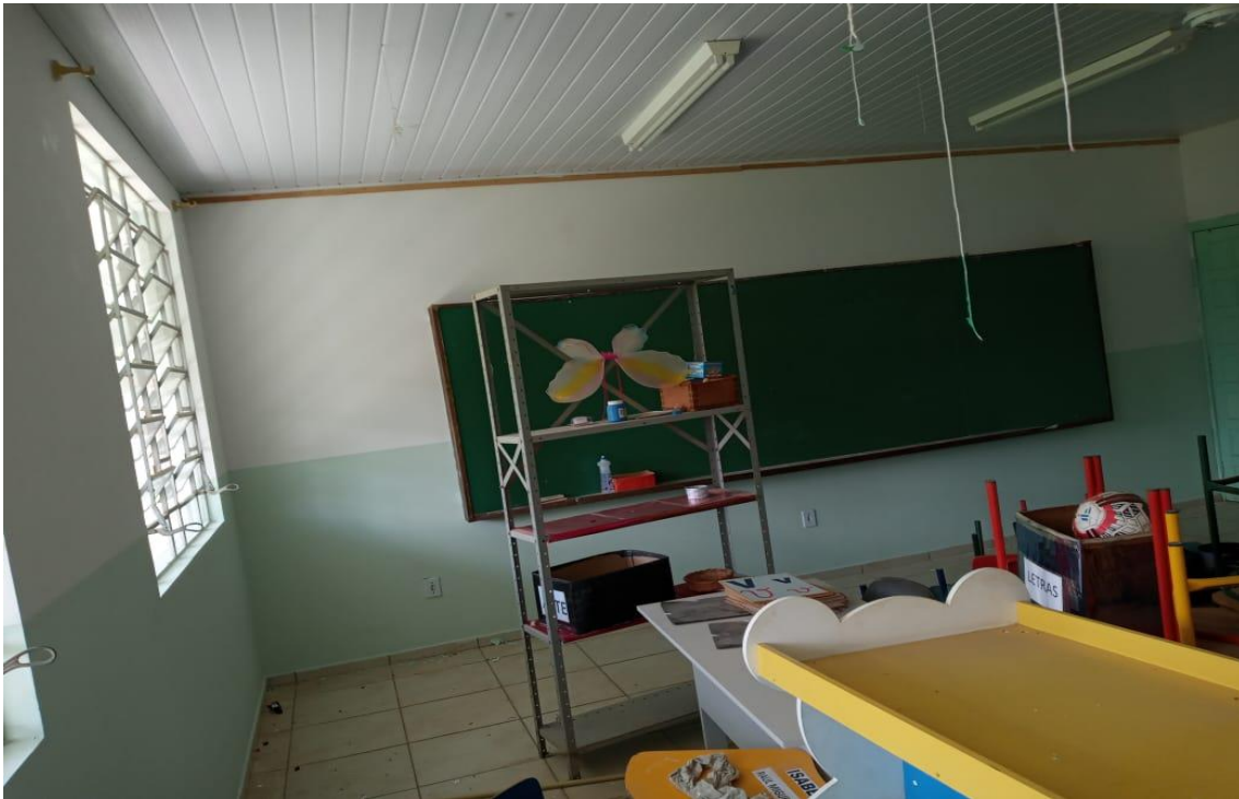
Foto 5 – Pintura interna e correções concluídos
