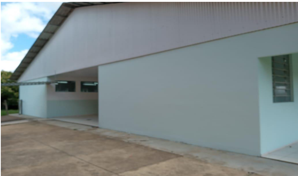
Foto 2 – Pintura externa e correções concluídos
