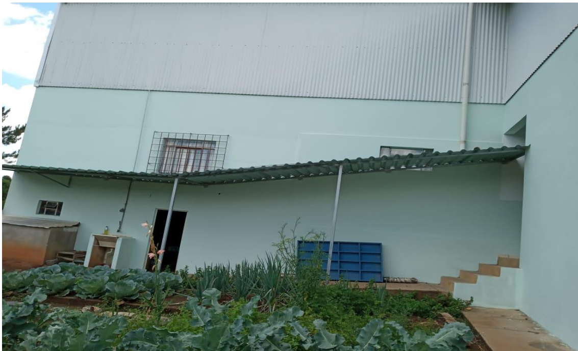
Foto 4 – Pintura externa e correções concluídos
