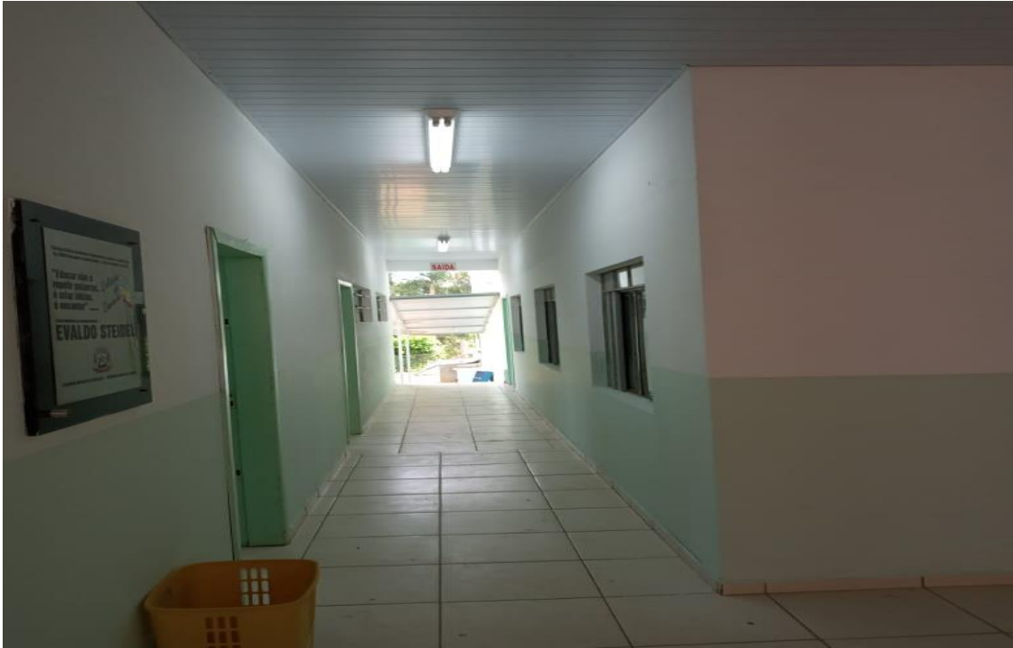
Foto 3 – Pintura interna e correções concluídos
