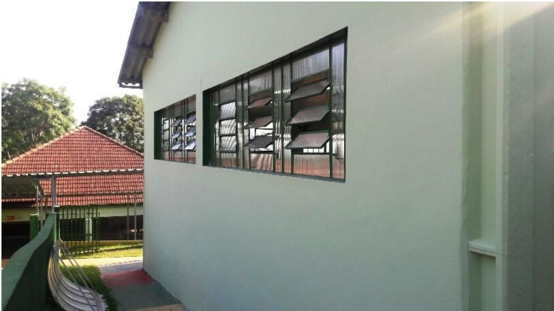
Foto 5 – Estrutura externa do galpão - concluído
