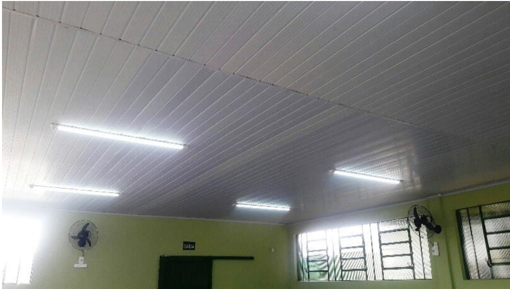
Foto 3 – Estrutura interna do galpão - concluído
