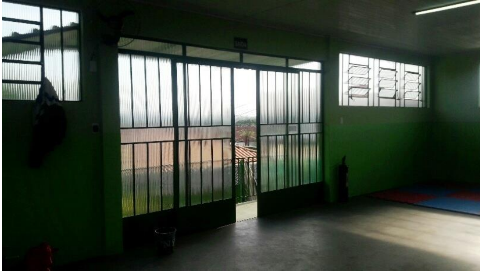
Foto 1 – Estrutura interna do galpão - concluído
