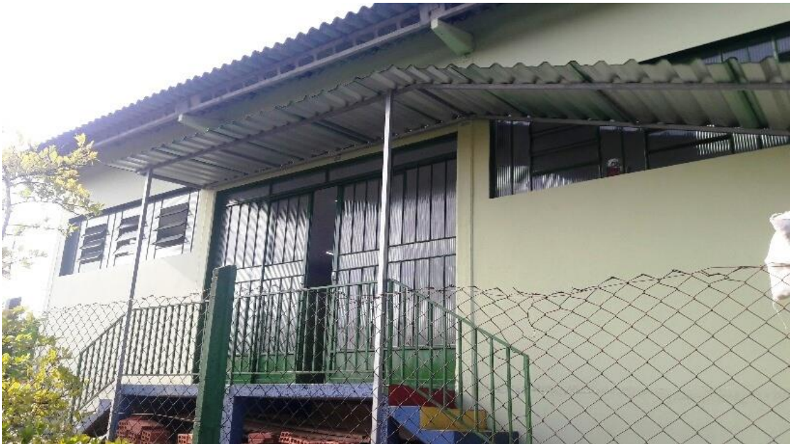
Foto 6 – Estrutura externa do galpão – concluído
