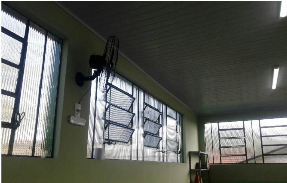
Foto 4 – Estrutura interna do galpão - concluído
