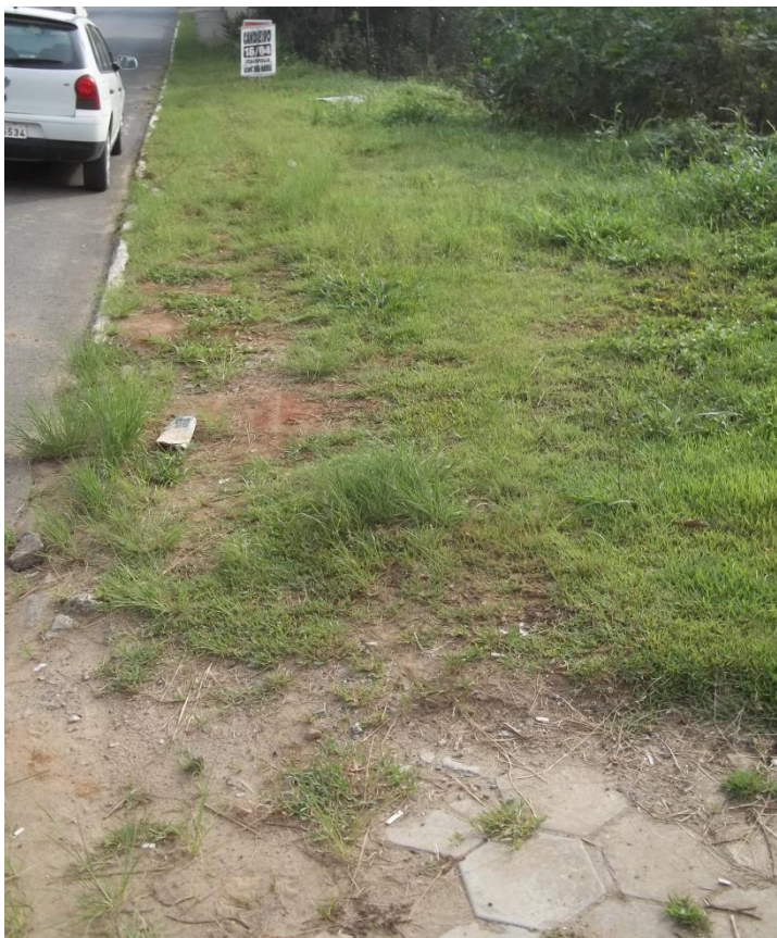
FOTO 06 ÁREA SEM CALÇAMENTO - 16/07/2017
