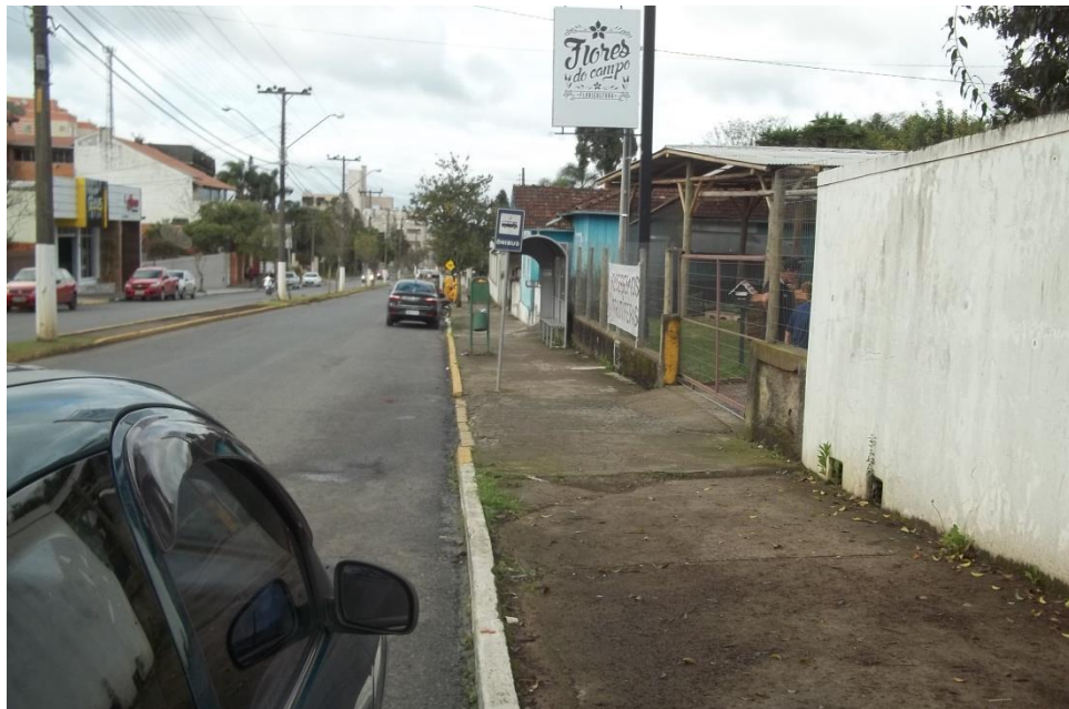
FOTO 38 CALÇADA COM PAVIMENTAÇÃO DETERIORADA - 16/07/2017
