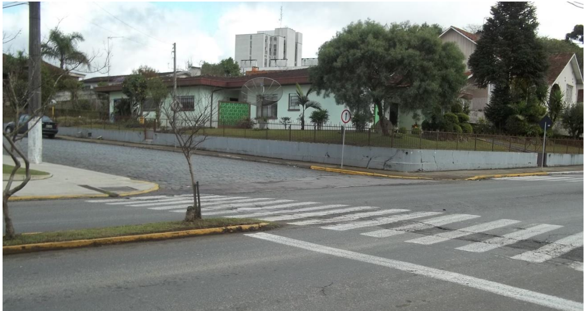
FOTO 35 ESQUINA SEM REBAIXO DE ACESSO PNE E FAIXA DE PEDESTRE SIMPLES – 16/07/2017
