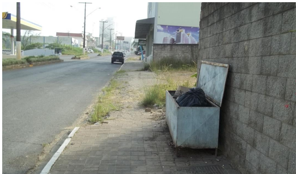
FOTO 16 AREA COM OBSTÁCULOS NA CALÇADA – 16/07/2017
