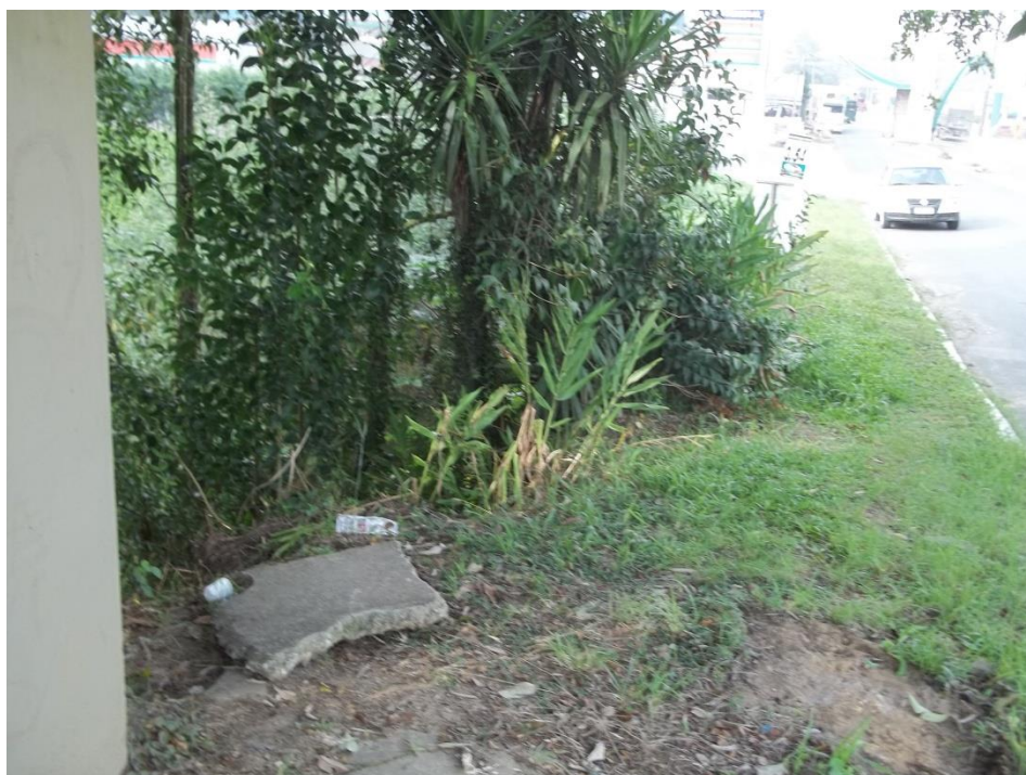
FOTO 04 ÁREA SEM CALÇAMENTO PRÓXIMO AO PORTAL DE ACESSO - 16/07/2017
