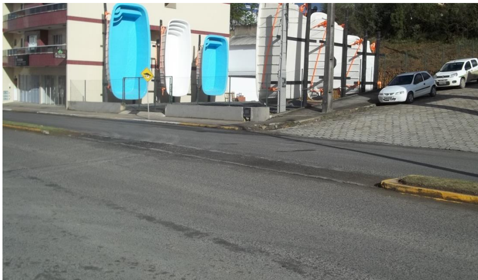
FOTO 26 ESQUINA COM PAVIMENTAÇÃO E MEIO FIO EM BOM ESTADO– 16/07/2017
