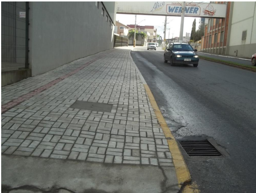
FOTO 24 CALÇADA COM PAVIMENTAÇÃO E BOCA DE LOBO EM BOM ESTADO- 16/07/2017
