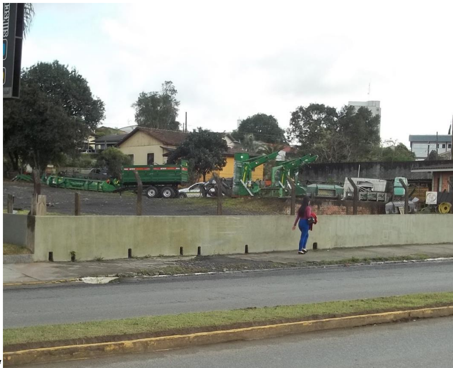
FOTO 30 CALÇADA COM PAVIMENTAÇÃO E MEIO FIO DETERIORADO– 16/07/2017
