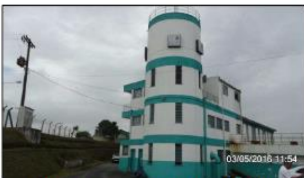
Figura 17 – Reservatório elevado com volume exclusivamente operacional.
