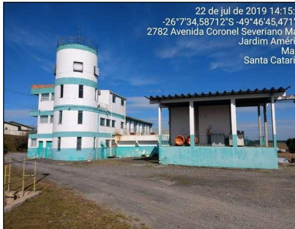
Figura 12 - ETA do SAA Central de Mafra
