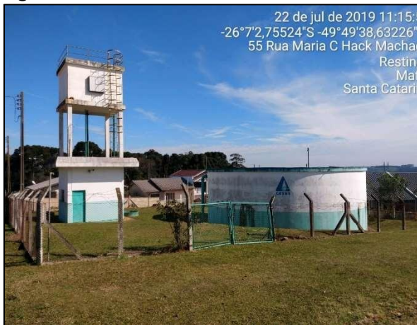
Figura 40 – Reservatórios R5 e R5-A.
