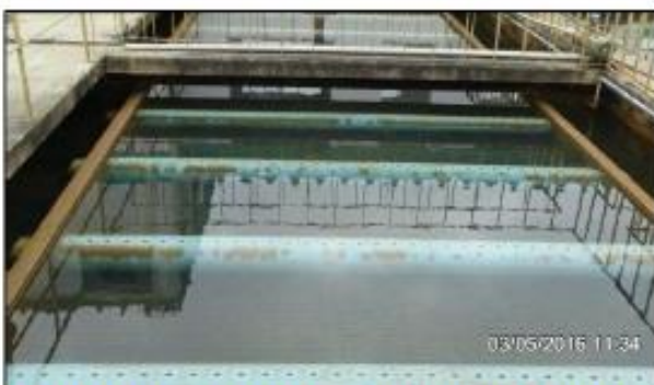
Figura 15 – Decantador de alta taxa com perfil retangular.
