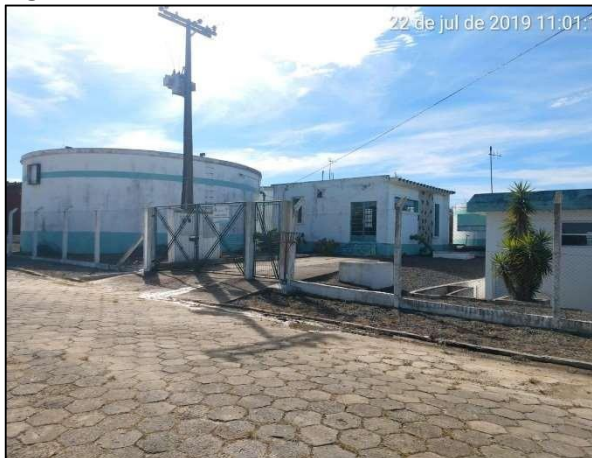
Figura 35 – Reservatórios R1 A/B/C e ERAT
