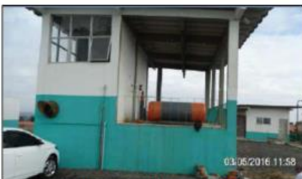
Figura 19 – Cilindros de Cl 2 .
