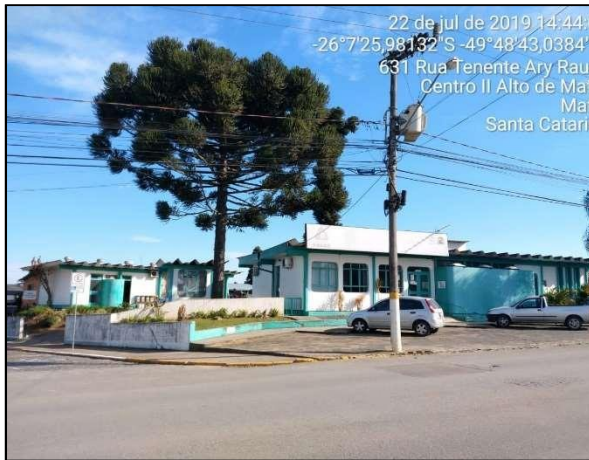
Figura 42 – Sede Administrativa e Atendimento Comercial da CASAN em Mafra/SC. Fonte: Insight (2019).
