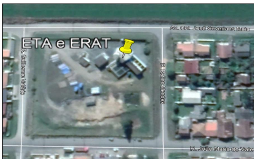
Figura 9 – Localização da ETA e ERAT do SAA Central de Mafra.
