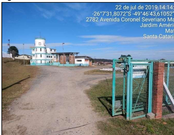
Figura 11 – ETA do SAA Central de Mafra
