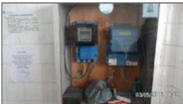
Figura 27 – Conversor do macromedidor de uma das AATs (de um total de três AATs).
