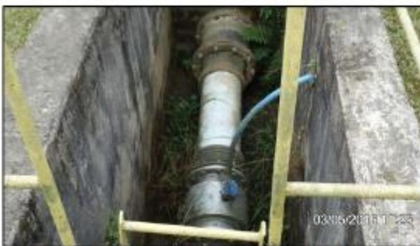
**Figura 13 – Adutora de chegada de água bruta dotada de macromedidor eletromagnético.**
