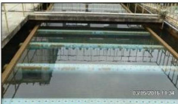
**Figura 15 – Decantador de alta taxa com perfil retangular.**
