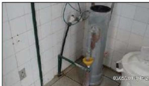
Figura 22 – Dosagem de Flúor (Fluorsilicato de Sódio) por Saturação.
