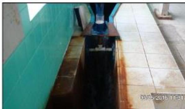
**Figura 14 – Calha Parshall para promoção de mistura rápida.**
