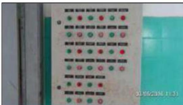
Figura 21 – Quadro de Comando das Unidades Mecânicas da ETA.
