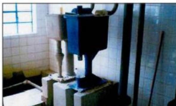
Figura 24 – Dosadores de Sulfato de Alumínio.
