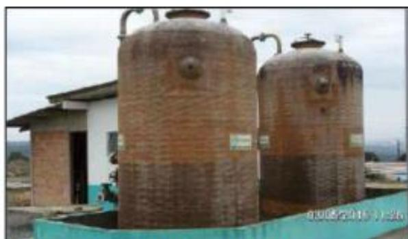
**Figura 18 – Reservatório de armazenamento do PAC.**
