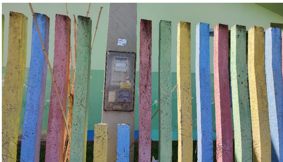
Padrão de Entrada de Energia Elétrica
