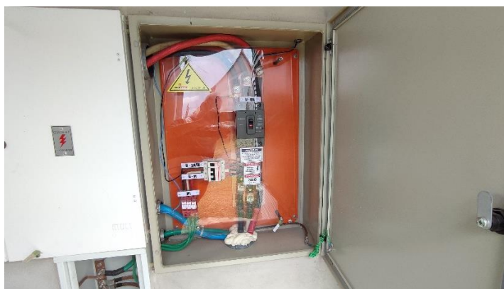
Disjuntor Geral do Padrão de Entrada de Energia Elétrica
