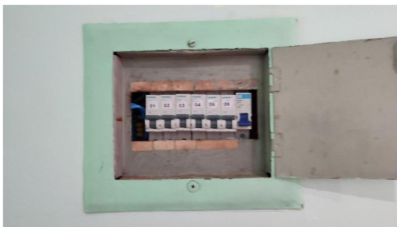
QDBT de Energia Elétrica
