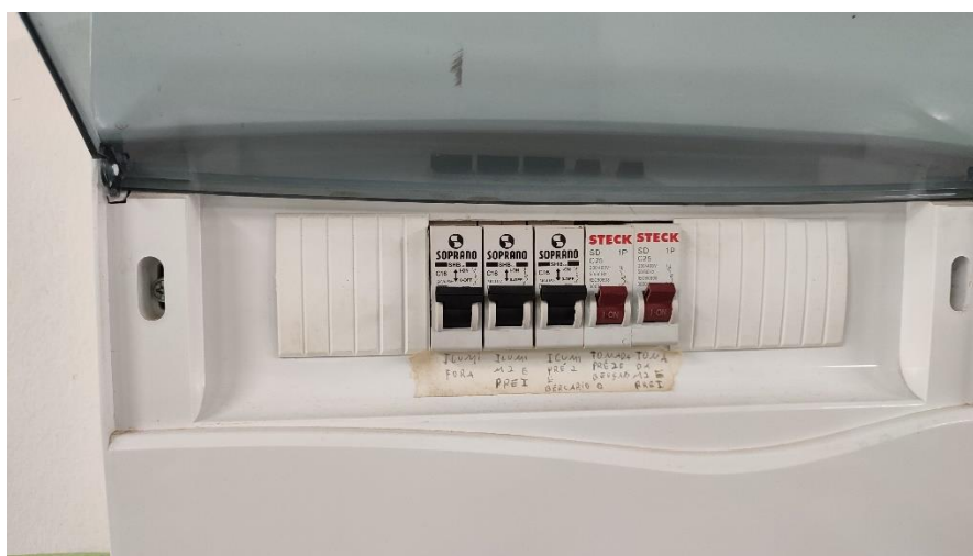
QDBT de Energia Elétrica
