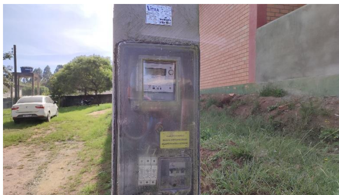
Padrão de Entrada de Energia Elétrica
