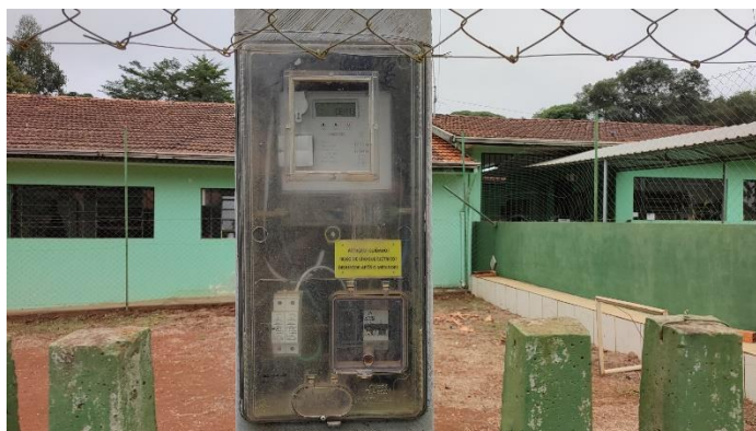
Padrão de Entrada de Energia Elétrica
