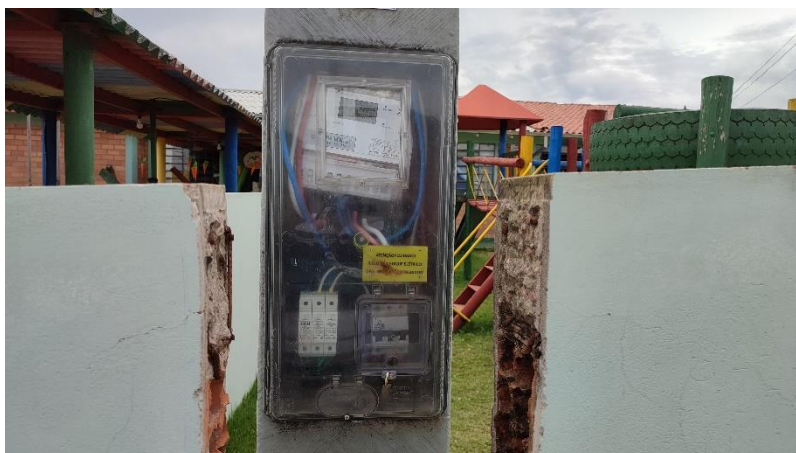
Padrão de Entrada de Energia Elétrica
