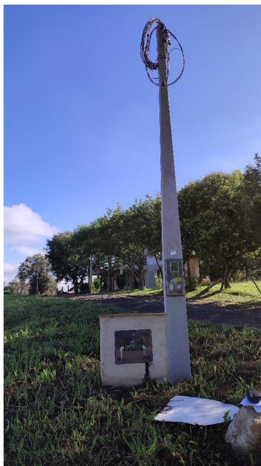
Padrão de Entrada de Energia Elétrica
