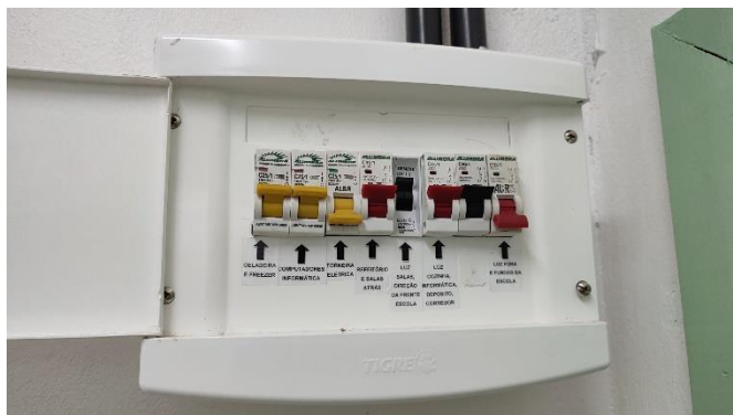
QDBT de Energia Elétrica
