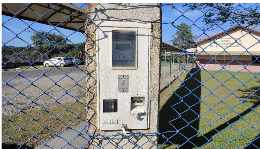
Padrão de Entrada de Energia Elétrica
