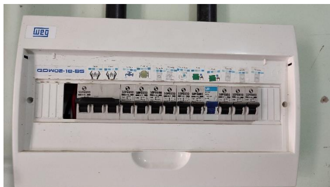
QDBT de Energia Elétrica
