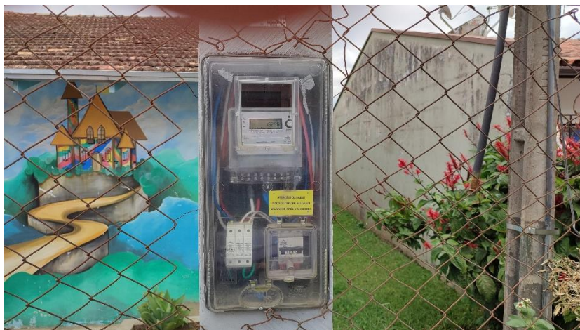
Padrão de Entrada de Energia Elétrica
