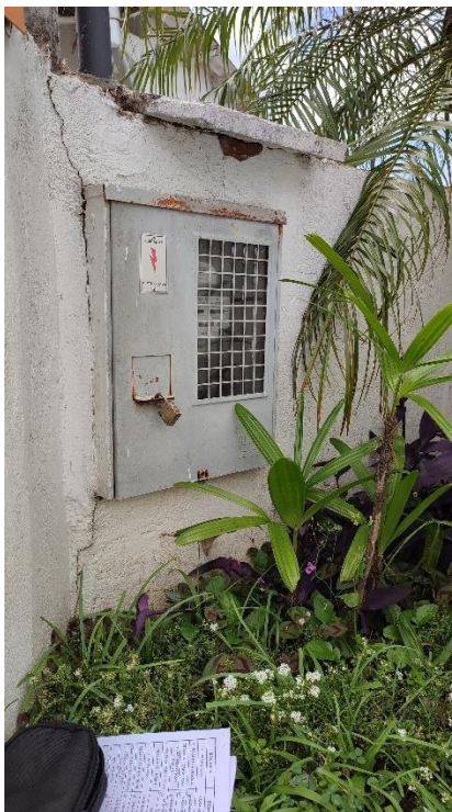
Padrão de Entrada de Energia Elétrica
