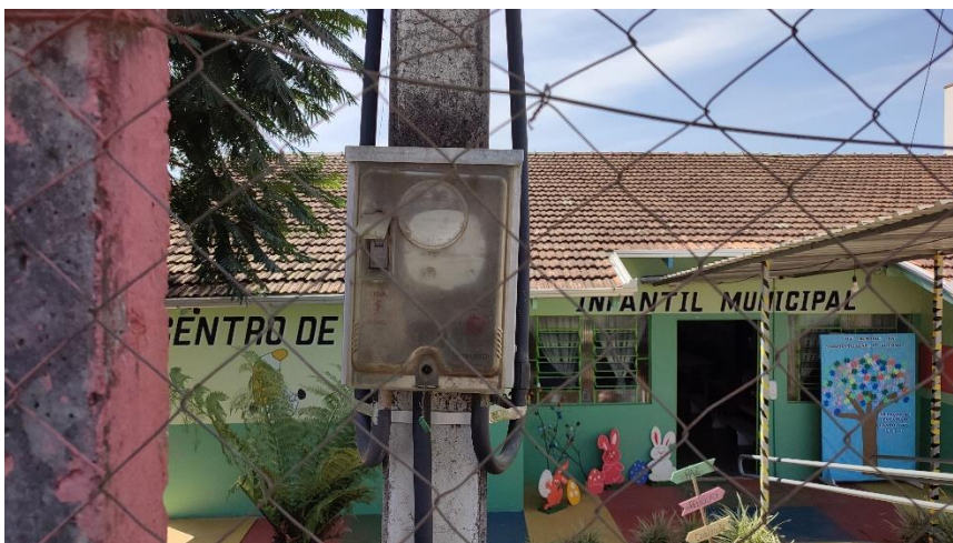
Padrão de Entrada de Energia Elétrica
