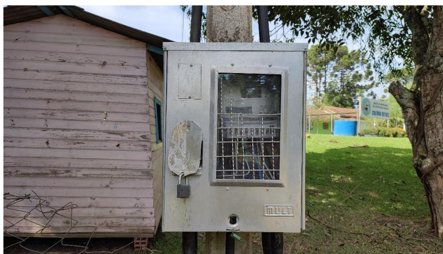
Padrão de Entrada de Energia Elétrica
