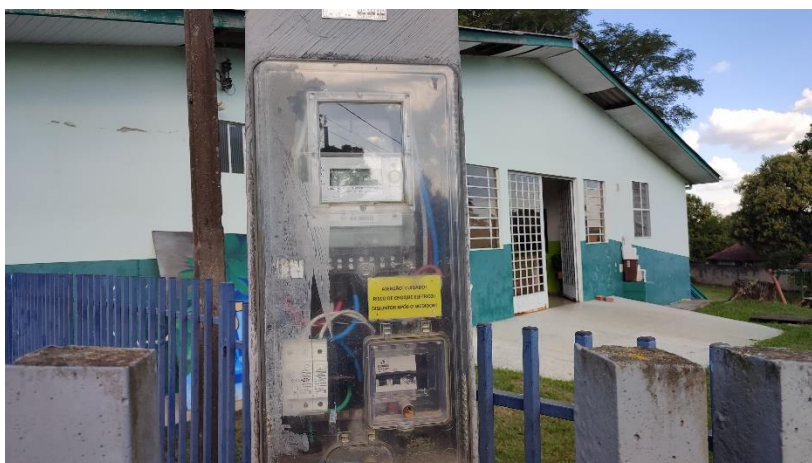
Padrão de Entrada de Energia Elétrica
