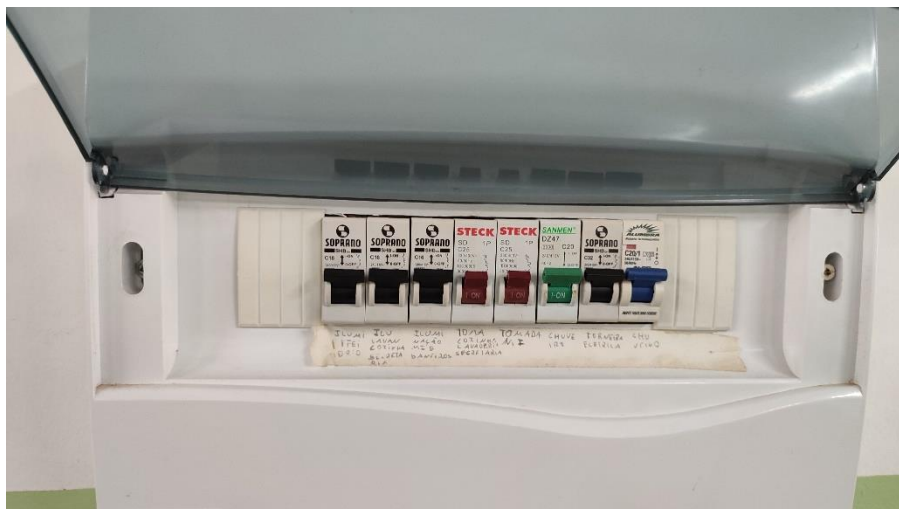
QDBT de Energia Elétrica
