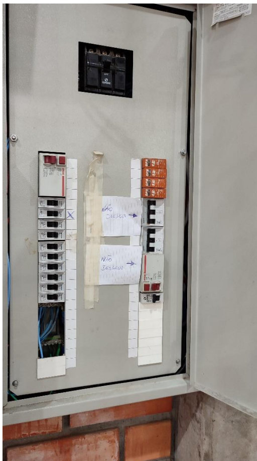
QDBT de Energia Elétrica
