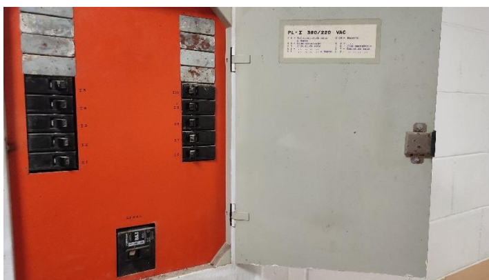
QDBT de Energia Elétrica
