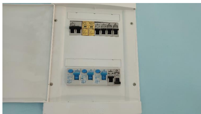
QDBT de Energia Elétrica
