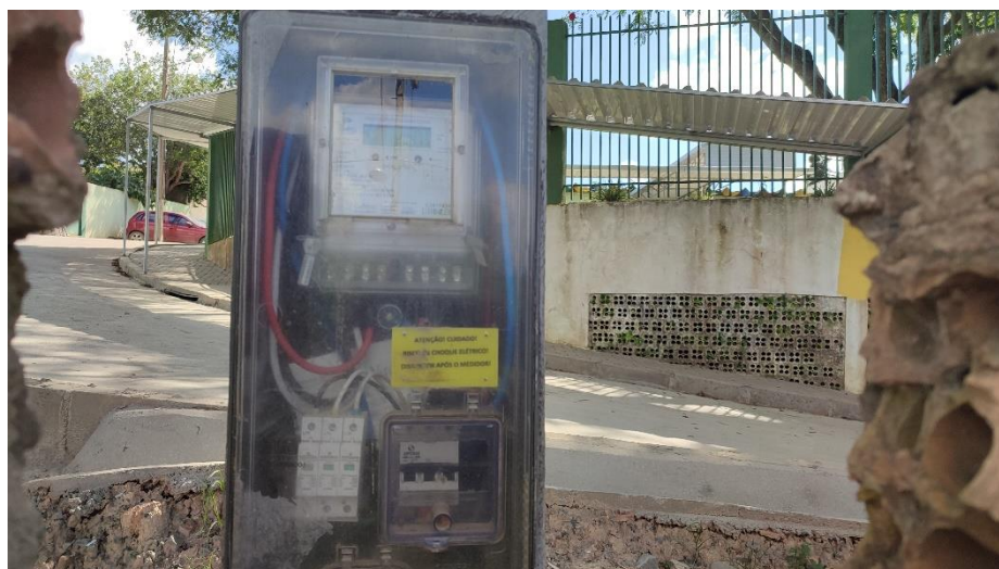
Padrão de Entrada de Energia Elétrica
