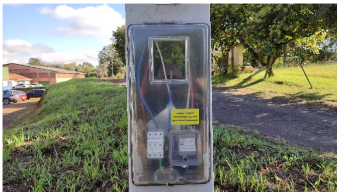
Padrão de Entrada de Energia Elétrica
