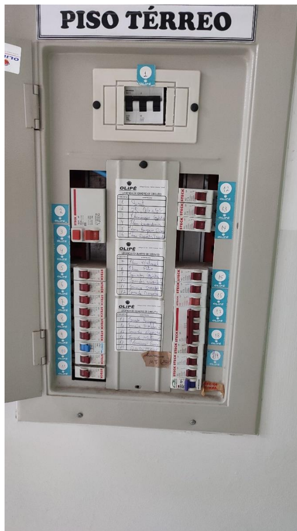
QDBT de Energia Elétrica
