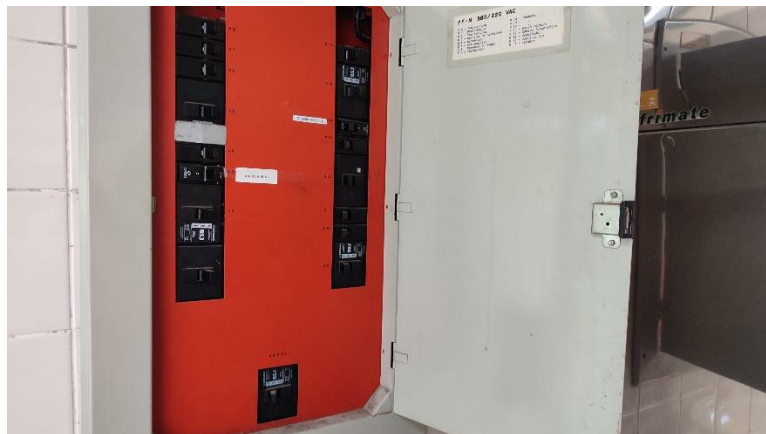
QDBT de Energia Elétrica
