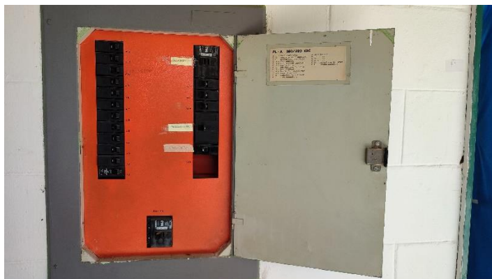
QDBT de Energia Elétrica
