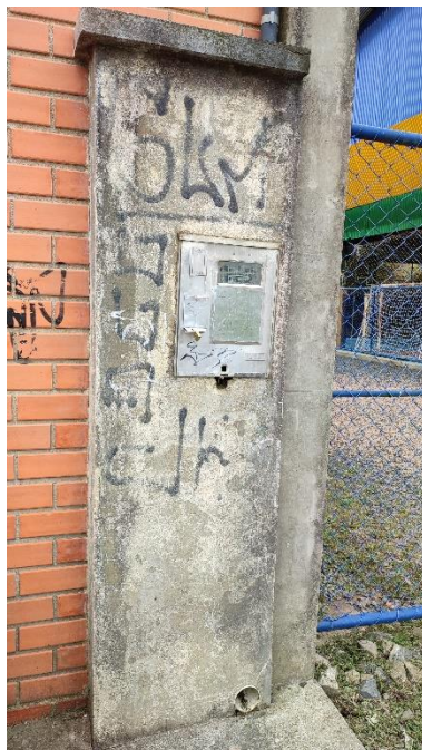
Padrão de Entrada de Energia Elétrica
