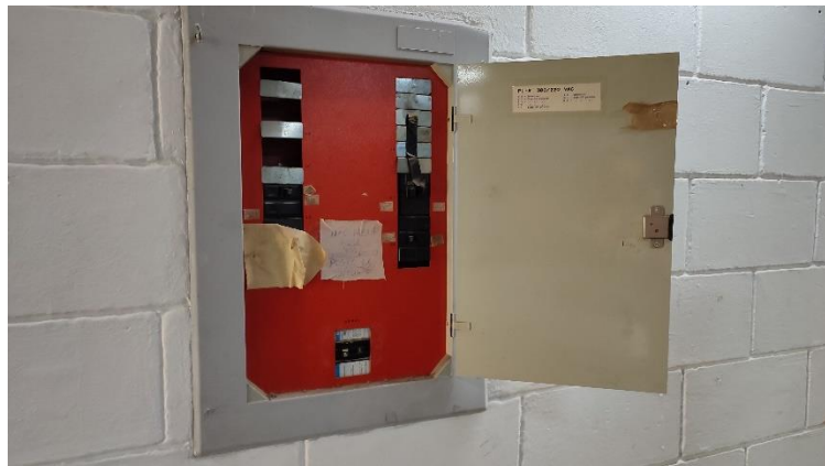
QDBT de Energia Elétrica
