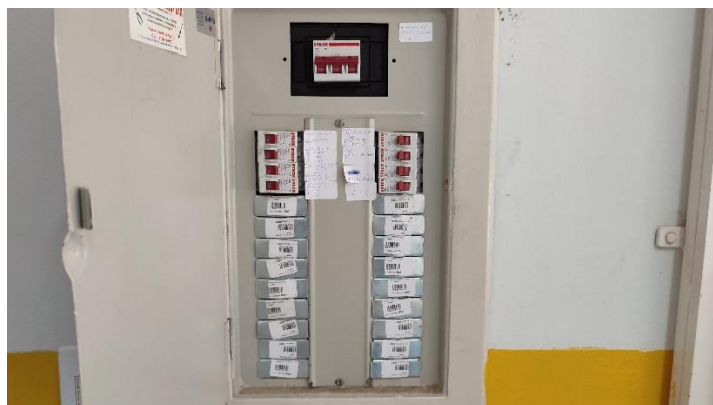
QDBT de Energia Elétrica
