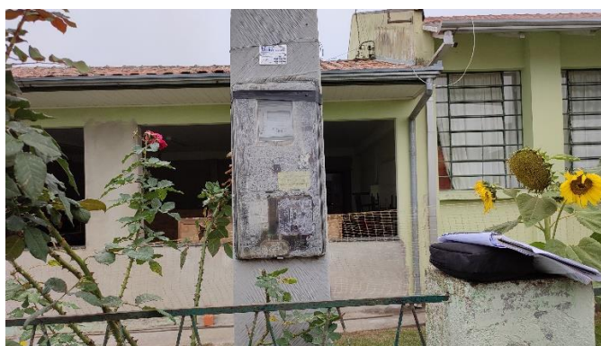
Padrão de Entrada de Energia Elétrica
