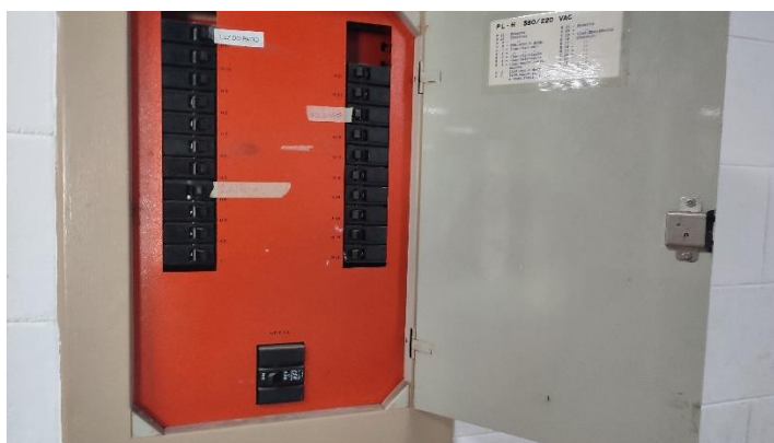
QDBT de Energia Elétrica
