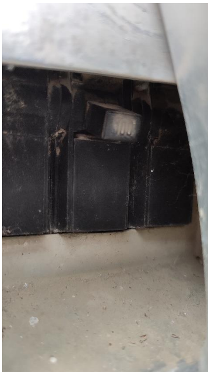
Disjuntor Geral do Padrão de Entrada de Energia Elétrica
