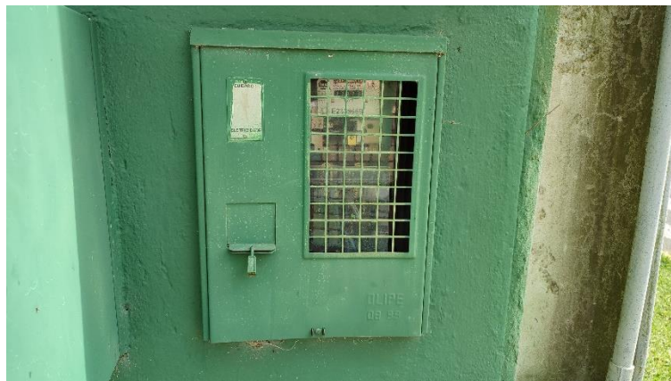
Padrão de Entrada de Energia Elétrica
