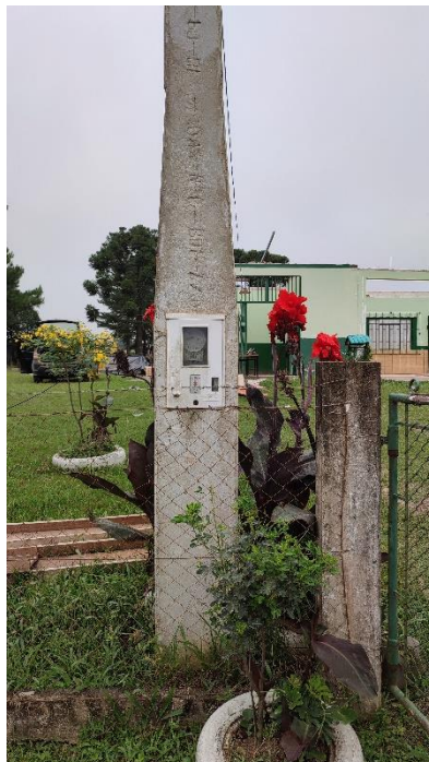
Padrão de Entrada de Energia Elétrica
