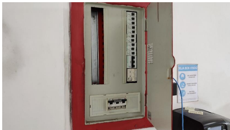
QDBT de Energia Elétrica
