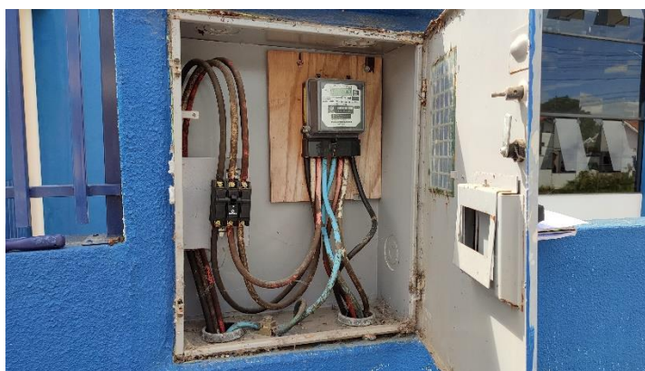
Padrão de Entrada de Energia Elétrica
