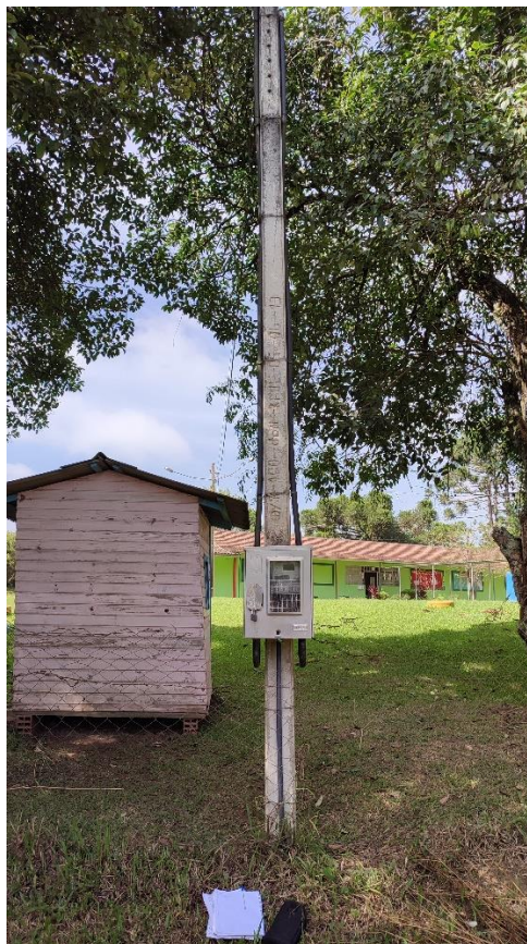
Padrão de Entrada de Energia Elétrica
