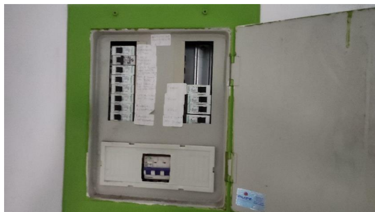
QDBT de Energia Elétrica
