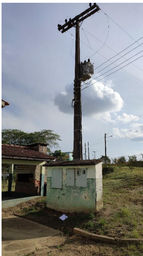
Padrão de Entrada de Energia Elétrica
