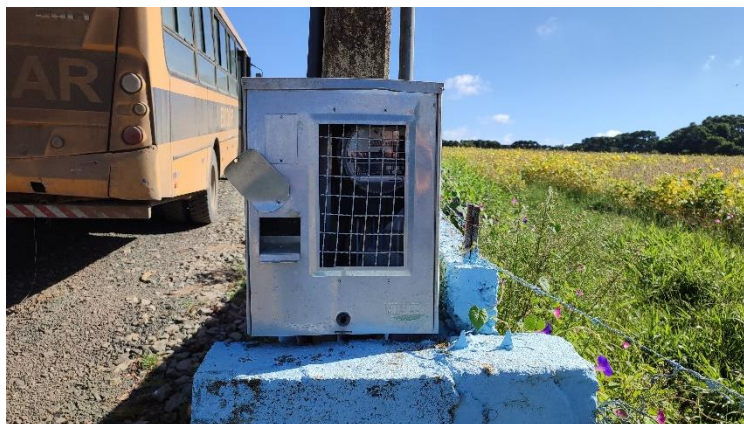
Padrão de Entrada de Energia Elétrica
