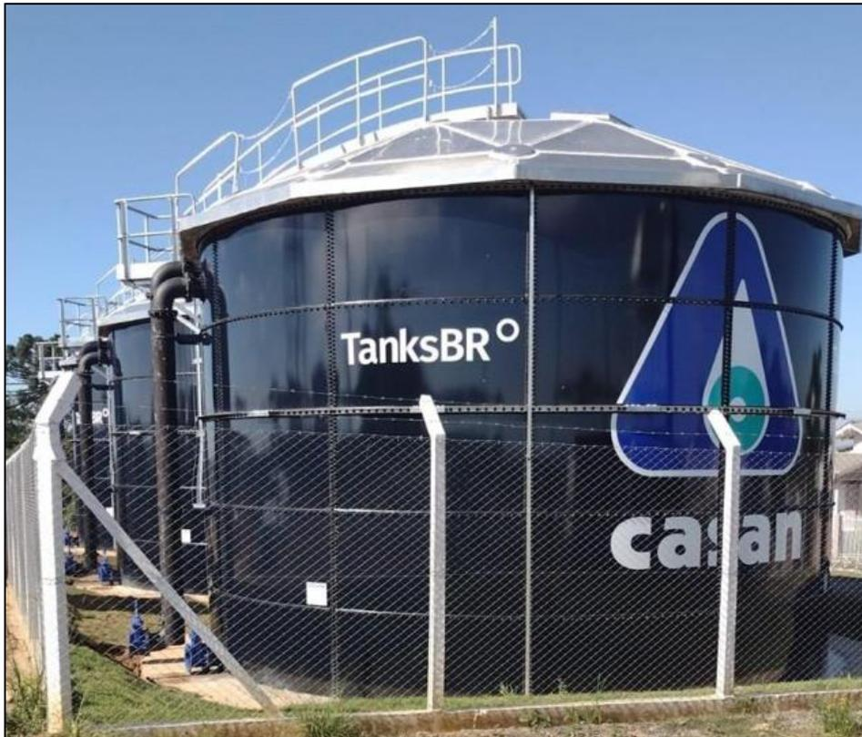
Figura 7 - Três Novos Reservatórios em Aço Vitrificado – 350 m<sup>3</sup> cada
