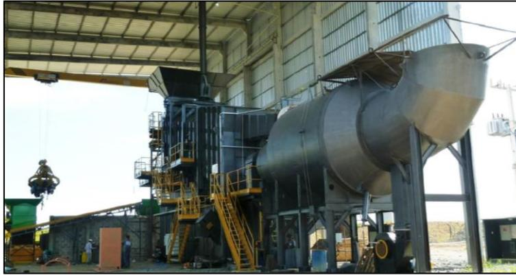
Foto 13 - Gaseificador instalado ao lado do Aterro Sanitário de Mafra/SC
